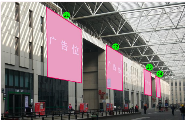
B50 展馆外墙广告 – 二层(16米层)车道
